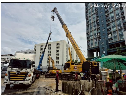
ภาพที่ 42 ควบคุมการกวาดแขน (Boom) ของเครนให้อยู่ ภายในพื้นที่ก่อสร้าง
