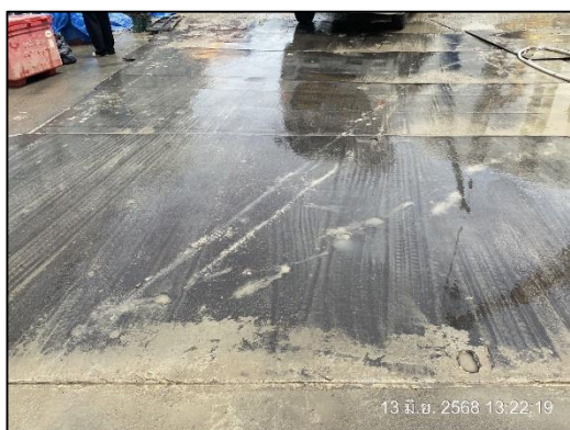
ภาพที่ 15 ปูแผ่นเหล็กอย่างหนาบริเวณพื้นที่โครงการ
