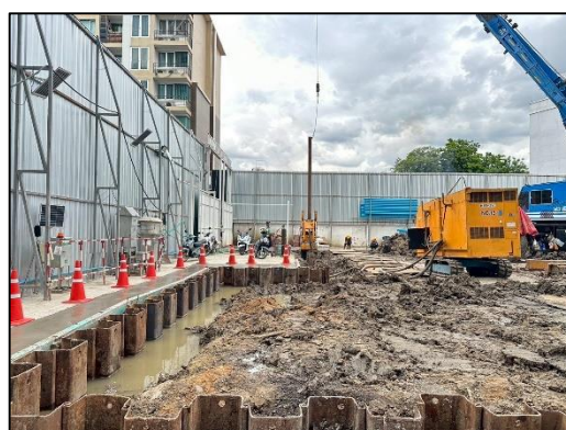
ภาพที่ 7 Sheet Pile
